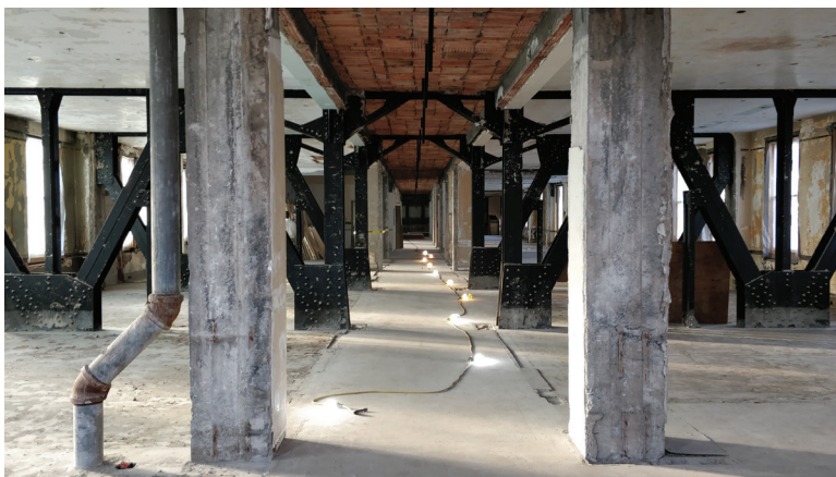
Westinghouse HQ, Hamilton, Ontario. Boarded up for over 30 years, this grand building has been reborn as a commercial and event space. With the help of City of Hamilton grants, its future was shifted from demolition to reuse. | Abandonné depuis plus de 30 ans, ce grand bâtiment renaît en tant qu'espace commercial et événementiel. Grâce à des subventions de la ville de Hamilton, ce bâtiment a été sauvé de la démolition pour la réutilisation.
