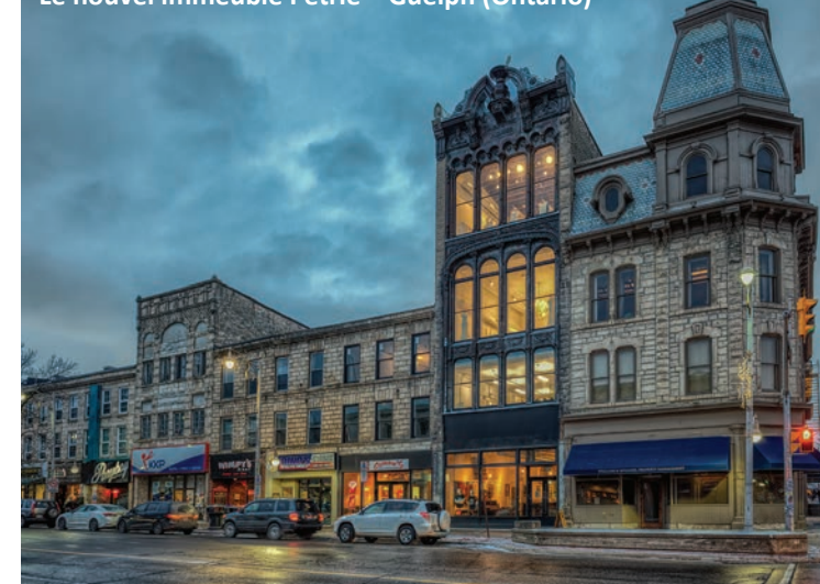
Le nouvel immeuble Petrie – Guelph (Ontario)
